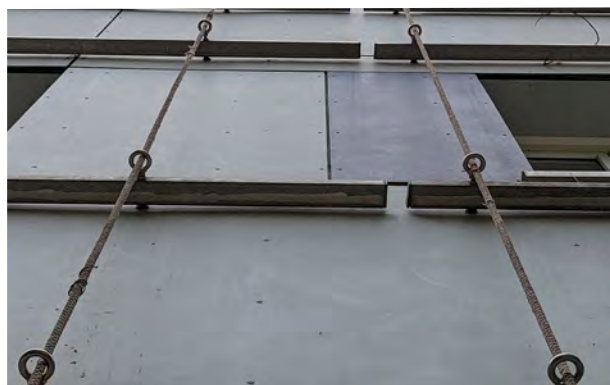
Abb. 34: Beispiel einer gespannten Anbringung. Quelle: BuGG
