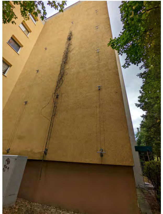
Abb. 73: Durchtrennte Gerüstkletterpflanze. Quelle: BuGG
