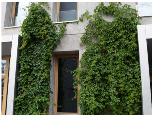
Abb. 172: Gerüstkletterpflanze (fünfblättriger Wilder Wein, Parthenocissus quinquefolia ) an Sichtbetonfassade. Quelle: BuGG
