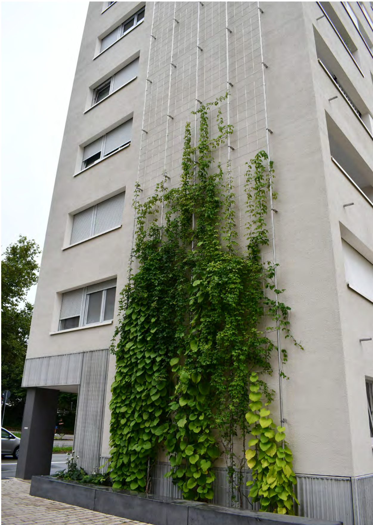
Abb. 168: Verwendung von Gerüstkletterpflanzen an einer passenden Wandkonstruktion. Quelle: BuGG
