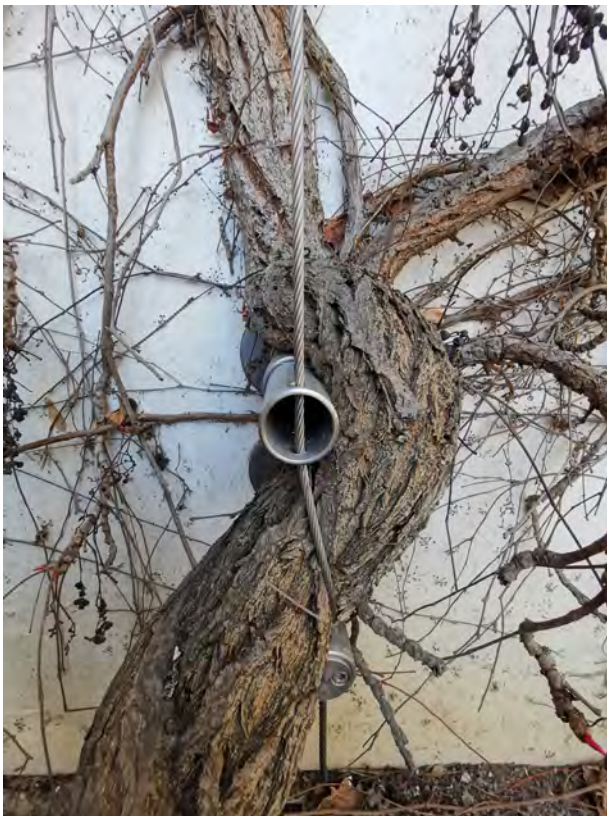
Abb. 78 Die Kletterhilfe ist zu gering dimensioniert für die genutzte Kletterpflanze. Quelle: BuGG
