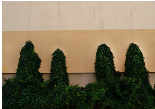
Abb. 99: Falsche Gerüstkletterpflanze (Fünfblättriger Wilder Wein, Parthenocissus quinquefolia ). Statt einer schlingenden Art an dem linearen Seilsystem wurde eine rankende Art genutzt. Quelle: BuGG
