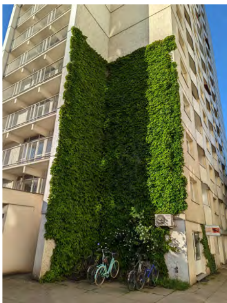
Abb. 189: Selbstklimmer an VHF sind aufgrund des negativ phototropen Wachses zu vermeiden. Quelle: BuGG
