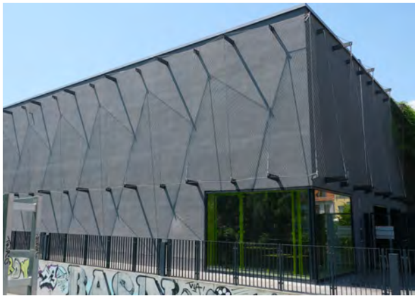
Abb. 83: Überdimensionierung der Kletterhilfe hinsichtlich des möglichen horizontalen Wuchsverhaltens einer Gerüstkletterpflanze. Quelle: BuGG
