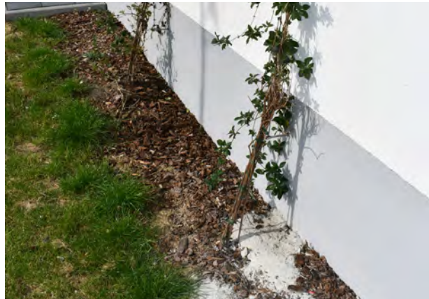
Abb. 52: Gegebenenfalls sind Bodenverbesserung, wie hier Einarbeiten von Sand, notwendig. Quelle: BuGG
