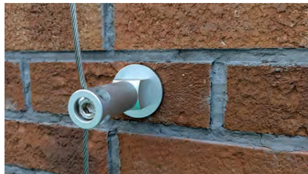
Abb. 176: Beispielhafte Kletterhilfe an Mauerwerk. Quelle: BuGG
