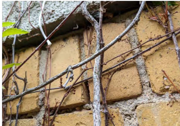
Abb. 66: Kontrolle der Fassade auf Beschädigung durch die Begrünung. Quelle: BuGG
