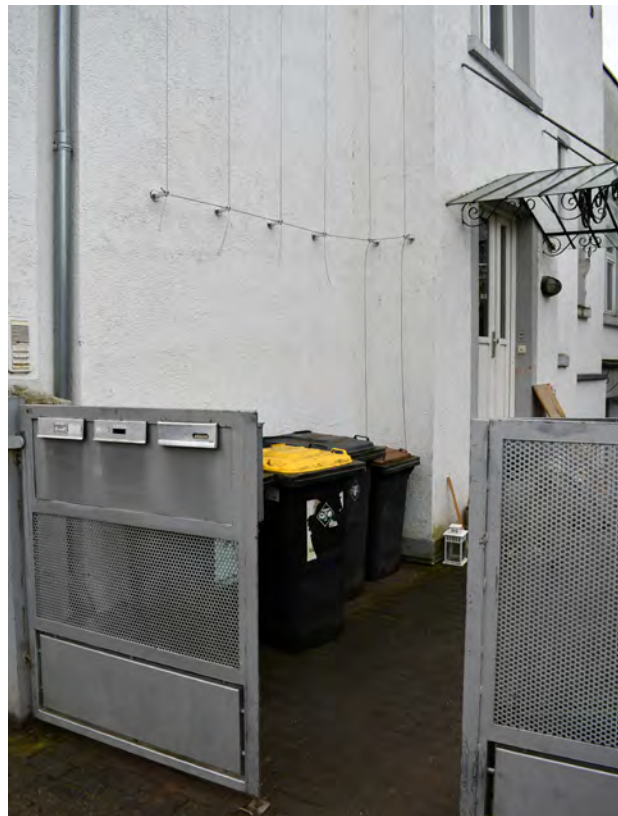
Abb. 82: Statt einer Pflanzfläche wurde der Raum für die Mülltonnen genutzt. Quelle: BuGG
