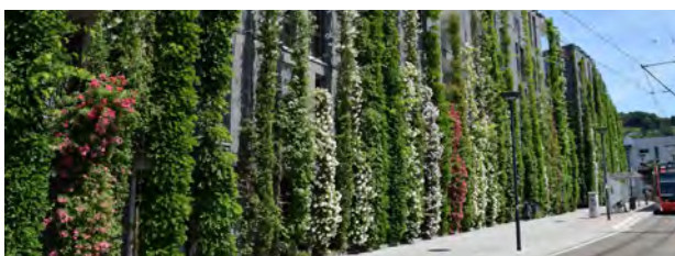
Abb. 198: Verschiedene Gerüstkletterpflanzen an Holzfassade eines Wohngebäudes. Quelle: BuGG
