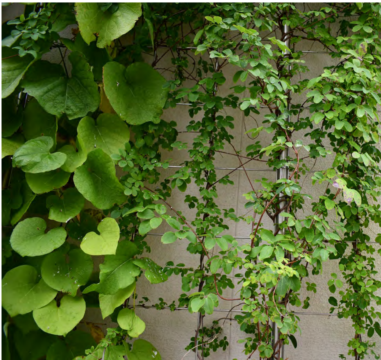
Abb. 109: Die richtige Kombination aus Kletterpflanze, Kletterhilfe und Fassadekonstruktion, sowie eine fachgerechte Pflege und Wartung sichert eine langfristige bodengebundene Fassadenbegrünung. Quelle: BuGG
