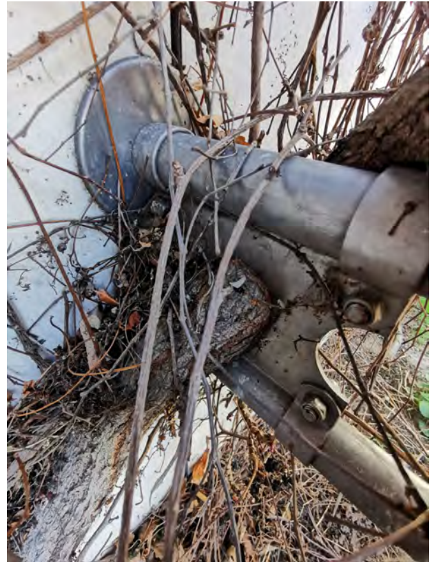
Abb. 77: Der zu geringe Abstand der scharfkantigen Halterung zur Wand kann den Pflanzenstamm beschädigen. Quelle: BuGG
