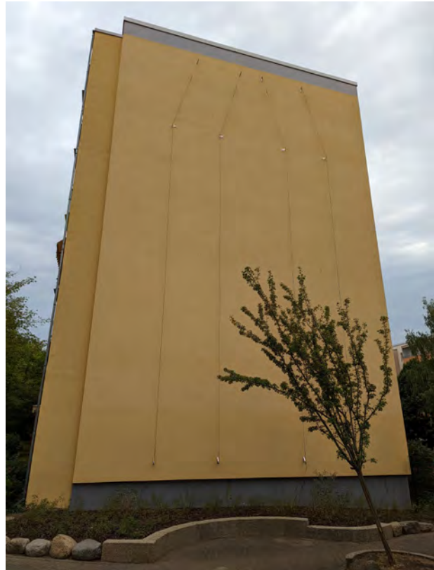
Abb. 80: Nach der Sanierung des Gebäudes wurde die Kletterhilfe montiert, jedoch keine Kletterpflanzen eingesetzt. Quelle: BuGG
