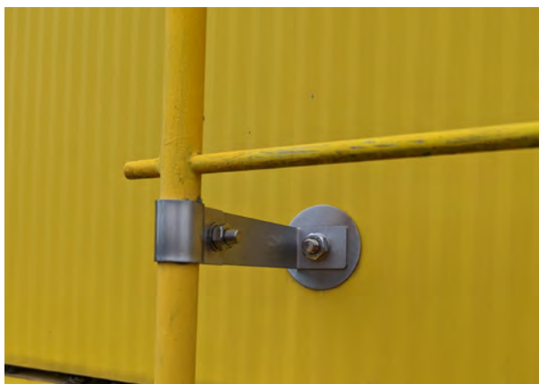
Abb. 38: Beispielhafte Halterung eines Gittersystems. Quelle: BuGG
