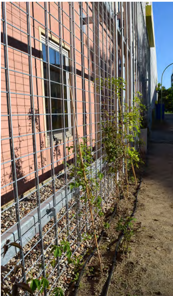
Abb. 26: Gittersystem (hier u. a. mit Fünflappigem Wildem Wein, Parthenocissus quinquefolia und Waldreben, Clematis ). Quelle: BuGG
