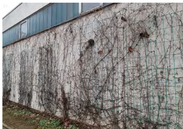
Abb. 65: Die Kontrolle von Kletterhilfen kann am besten in der Vegetationsruhe geschehen. Quelle: BuGG
