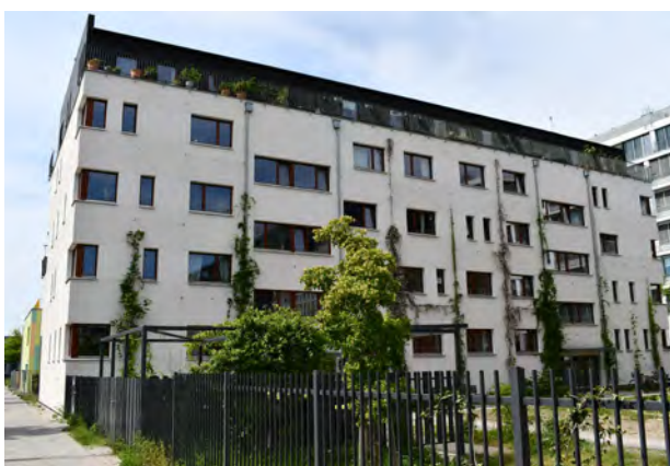
Abb. 179: Gerüstkletterpflanzen zwischen Fassadenöffnungen an WDVS. Quelle: BuGG
