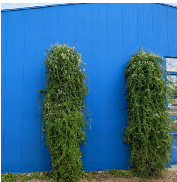
Abb. 183: Gerüstkletterpflanze ( Fallopia baldschuanica ) an Metallfassade. Quelle: BuGG
