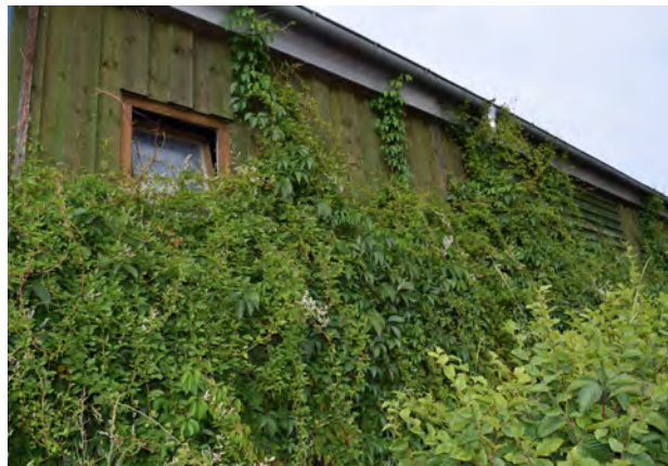
Abb. 108: Selbstklimmer wie Wilder Wein und Efeu sollten nicht an Holzfassaden gesetzt werden, um eine mögliche höhere Feuchtebelastung aufgrund des direkten Wuchses zu vermeiden. Quelle: BuGG
