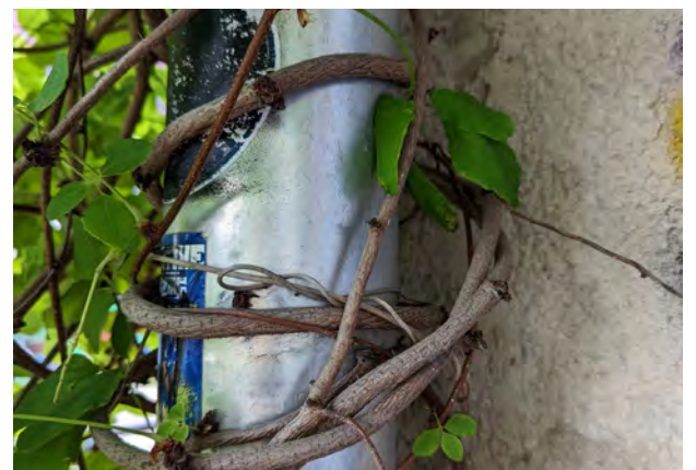
Abb. 106: Wuchs von Akebie ( Akebia quinata ) entlang des Regenabflussrohrs. Quelle: BuGG
